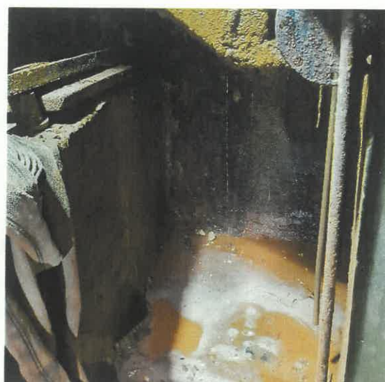
Fot. 28. Poziom -57,3m – brak prawidłowego odprowadzenia wody technologicznej, znaczna ilość wody zalega na poziomie stropów, spływa po elementach konstrukcyjnych powodując ich korozję i degradację -zdjęcie wykonane w 2023 r.
