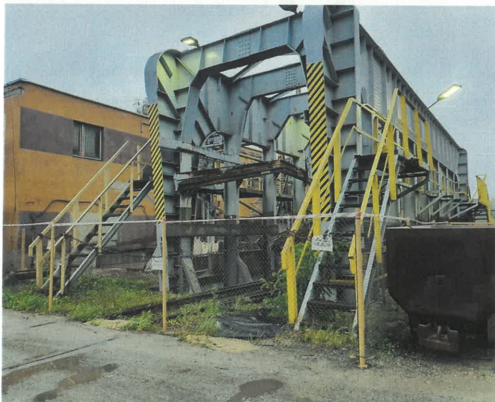
Fot. 3. Widok na most rozładowczy i konstrukcję zabezpieczającą wlot zbiornika – zdjęcie wykonano w 2023 r.
