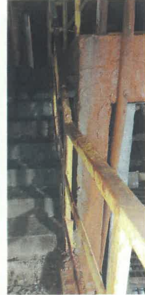
Fot. 24. Barierki zabezpieczone antykorozyjnie powłoką malarską – zdjęcie wykonano w 2023r.
