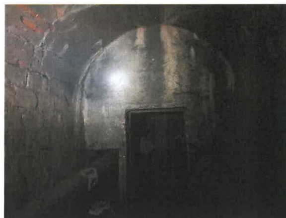
Fot. 41. Luneta – znaczna korozja stalowych elementów stolarki drzwiowej – zdjęcie wykonane w 2023r.
