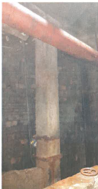
Fot. 20. Słupy żelbetowe na poziomie -57,3m – podłużne spękania słupów podpierających strop na poziomie -52,3m zabezpieczone tymczasowo przez Użytkownika – zdjęcia wykonane w 2023r.
