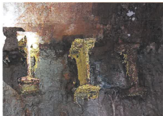
Fot. 31. Poziom -52,3m – Korozja elementów stabilizujących zbiornika. – zdjęcie wykonano w 2025 r. W 2023r. Użytkownik wykonał doraźne zabezpieczenie stalowych elementów stabilizacyjnych zbiornika. Zastosowane zabezpieczenie było wykonane doraźnie i nie zostało dopasowane do warunków panujących w obiekcie. Znaczna korozja elementów stabilizacyjnych świadczy o braku regularnych konserwacji przeprowadzanych przez Użytkownika. Miejscowo stan konstrukcji pogarsza się w szybkim tempie. Należy pilnie oczyścić widoczne części konstrukcyjne oraz zabezpieczyć w sposób adekwatny do warunków panujących w obiekcie.
