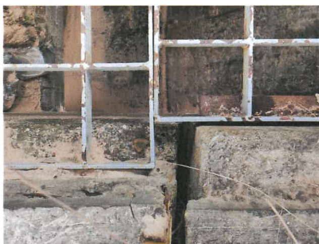
Fot. 7. Widok na ściany i przerwę dylatacyjną zbiornika piasku wykonane w 2023 r.
