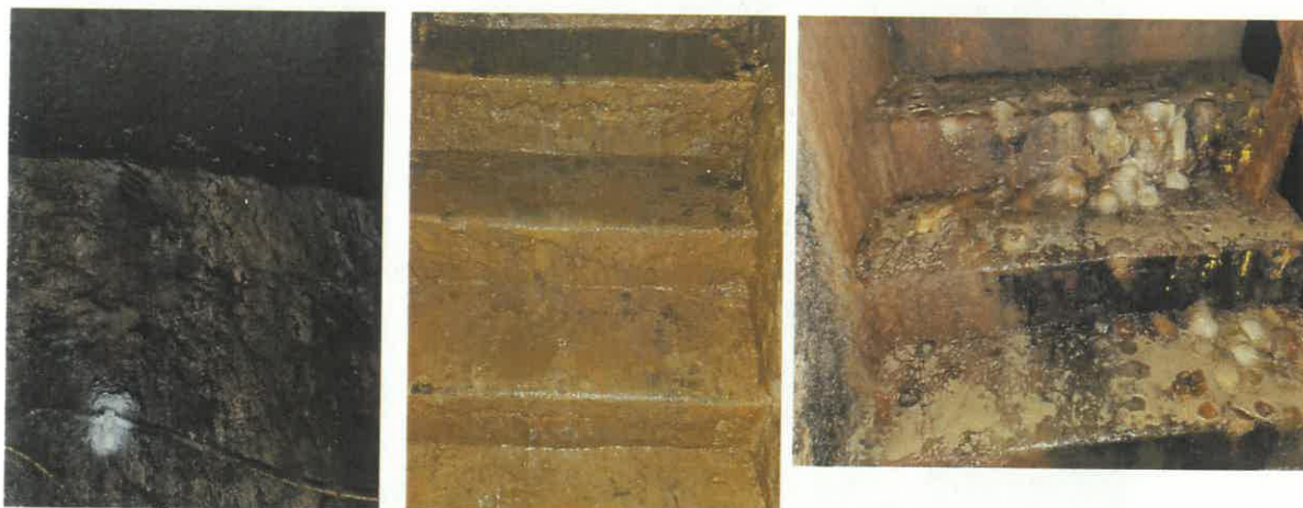
Fot. 16. Ściany pomieszczeń poniżej zbiornika kamienia i piasku – wykwyty solne powstałe na skutek oddziaływania wody wraz z zawartymi w niej związkami na ściany obiektu – zdjęcie wykonane w 2023 r.
