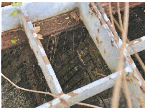
Fot. 7. Widok na ściany i przerwę dylatacyjną zbiornika piasku wykonane w 2023 r.
