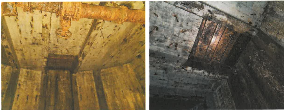
Fot. 14. Prześwity korozyjne płyty stropowej na poziomie -52,300m – zdjęcie wykonane w 2023r.
