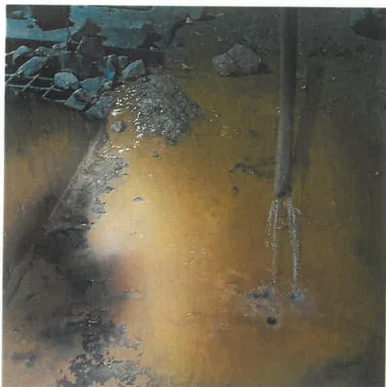
Fot. 28. Poziom -57,3m – brak prawidłowego odprowadzenia wody technologicznej, znaczna ilość wody zalega na poziomie stropów, spływa po elementach konstrukcyjnych powodując ich korozję i degradację -zdjęcie wykonane w 2023 r.
