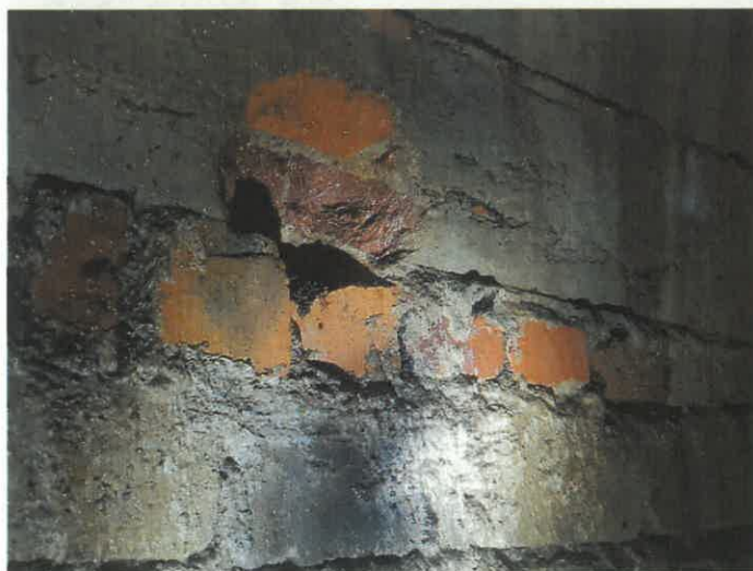
Fot. 47. Luneta - Ubytki w powłoce tynkarskiej, materiale ceglanym i spoinowaniu ścian – zdjęcie wykonane w 2023 r.
