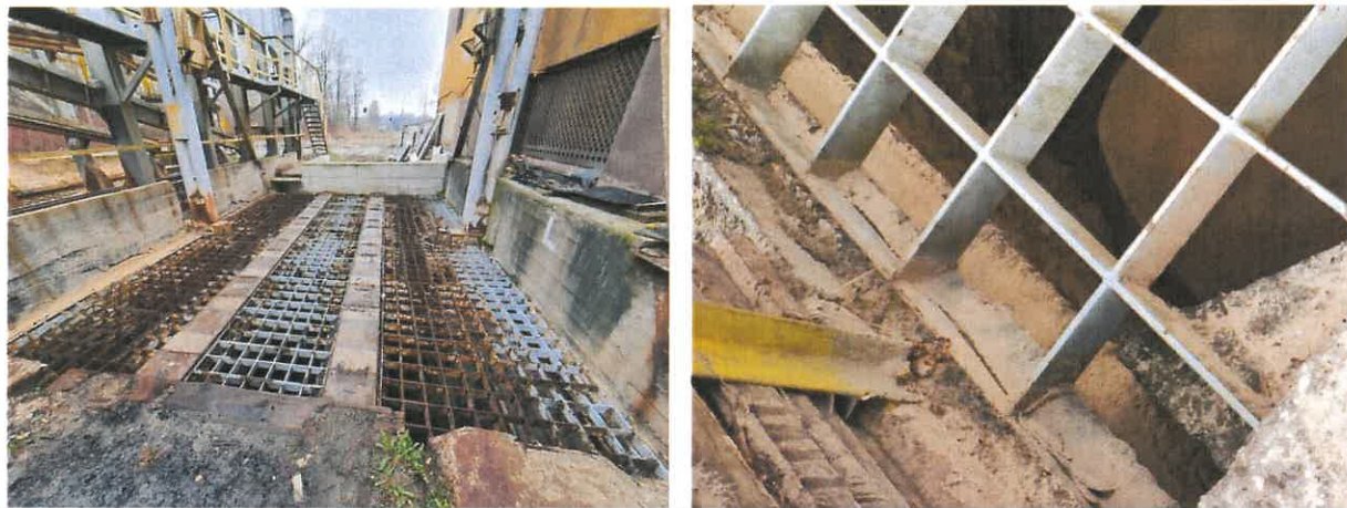
Fot. 1. Widok na kratę przykrywającą wlot zbiornika – zdjęcie wykonane w 2023 r.
