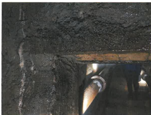
Fot. 41. Luneta – znaczna korozja stalowych elementów stolarki drzwiowej – zdjęcie wykonane w 2023r.
