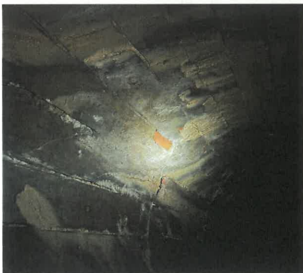
Fot. 47. Luneta - Ubytki w powłoce tynkarskiej, materiale ceglanym i spoinowaniu ścian – zdjęcie wykonane w 2023 r.
