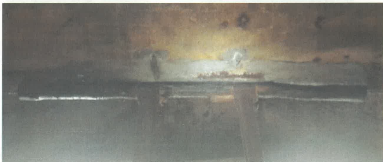
Fot. 11. Belka stropowa żelbetowa podpierająca strop na poziomie -52,300m.
