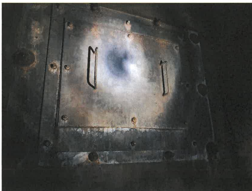
Fot. 9. Widok na ściany oraz stalowe elementy w kanale uciezkowym wykonane w 2023r.
