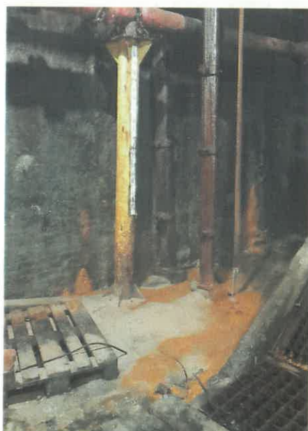
Fot. 29. Poziom -57,3m – w dalszym ciągu brak prawidłowego odprowadzenia wody technologicznej. Znaczna ilość wody w dalszym ciągu zalega na poziomie stropów, spływa po elementach konstrukcyjnych powodując ich korozję i degradację - zdjęcie wykonane w 2025 r. Należy zaplanować poprawne odprowadzenie wody technologicznej oraz zabezpieczenie elementów konstrukcyjnych i niekonstrukcyjnych przed oddziaływaniem wody z agresywnymi związkami chemicznymi.
