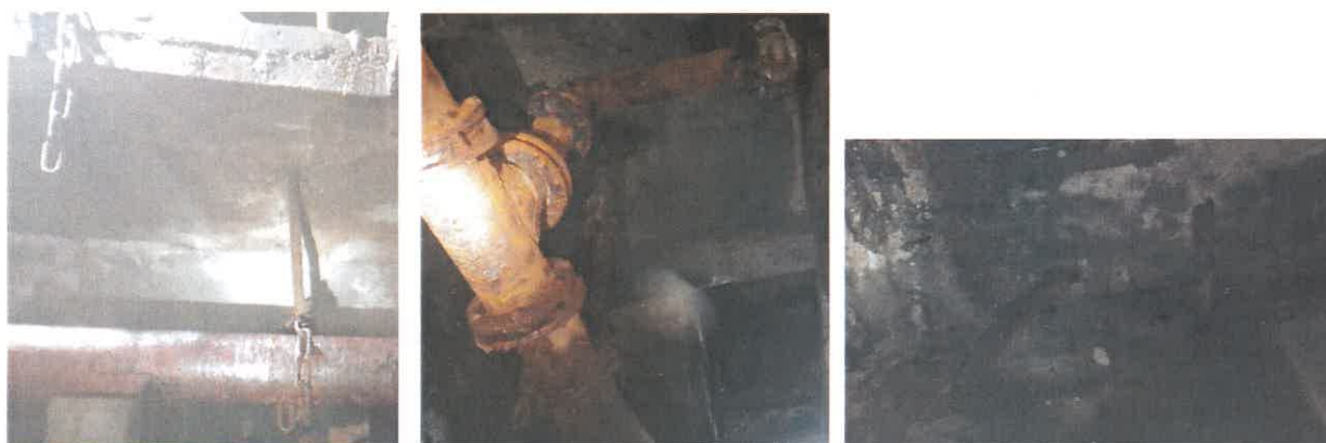
Fot. 34. Korodujące elementy stalowe – zdjęcia wykonano w 2023 r.
