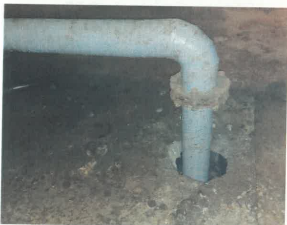
Fot. 36. Zdjęcie wykonane w 2025 r. Niezabezpieczone otwory technologiczne w stropie. Nieużywane otwory technologiczne należy zaślepić. Do czasu wykonania kompleksowego remontu należy zabezpieczyć przed osobami postronnymi.
