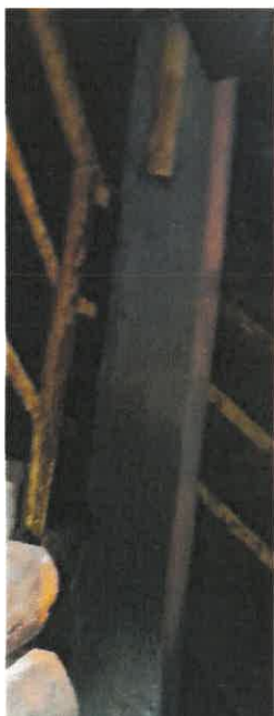
Fot. 20. Słupy żelbetowe na poziomie -57,3m – podłużne spękania słupów podpierających strop na poziomie -52,3m zabezpieczone tymczasowo przez Użytkownika – zdjęcia wykonane w 2023r.
