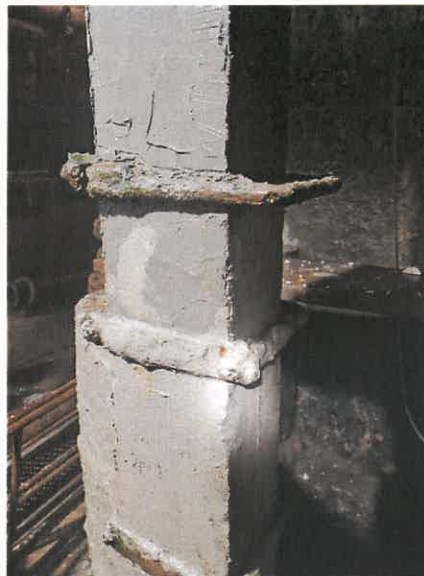
Fot. 20. Słupy żelbetowe na poziomie -57,3m – podłużne spękania słupów podpierających strop na poziomie -52,3m zabezpieczone tymczasowo przez Użytkownika – zdjęcia wykonane w 2023r.
