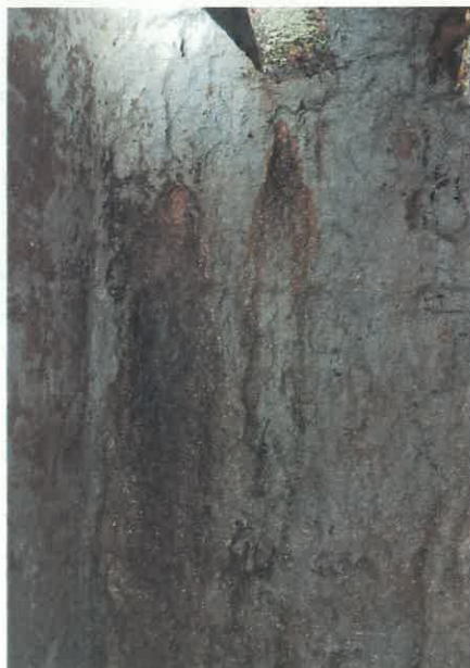
Fot. 26. Naprawy nieszczelności w ścianach żelbetowych – zdjęcie wykonane w 2023r.
