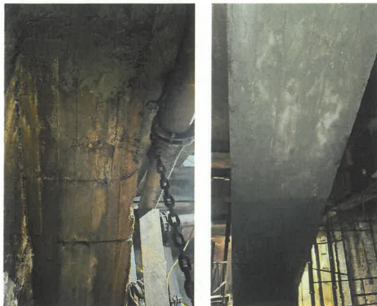
Fot. 18. Zsuwnia pomiędzy poziomem -52,3m i poziomem -57,3m – zdjęcie wykonane w 2023r.
