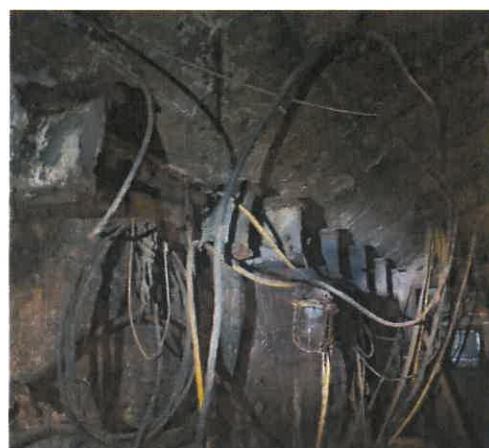
Fot. 30. Poziom -52,3m – znaczna korozja stalowych elementów konstrukcyjnych zbiornika podsadzowego, pełniących funkcję elementów stabilizujących obiekt. Brak dostępu do elementów stalowych od zewnątrz. Od wewnątrz Użytkownik wykonał próby spowolnienia korozji – zdjęcie wykonano w 2023r.
