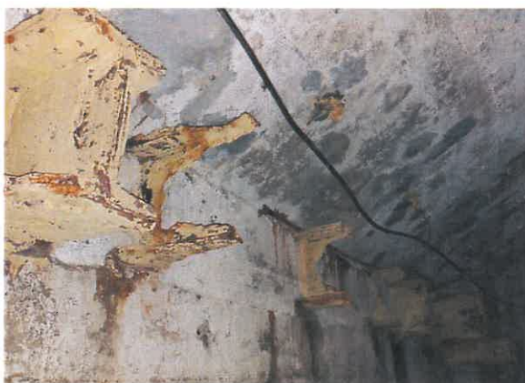
Fot. 30. Poziom -52,3m – znaczna korozja stalowych elementów konstrukcyjnych zbiornika podsadzowego, pełniących funkcję elementów stabilizujących obiekt. Brak dostępu do elementów stalowych od zewnątrz. Od wewnątrz Użytkownik wykonał próby spowolnienia korozji – zdjęcie wykonano w 2023r.
