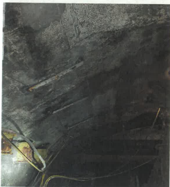
Fot. 13. Naprawy warstwy otulającej pręty zbrojeniowe wykonane w żelbetowym leju zbiornika- zdjęcie wykonane od strony pomieszczeń poniżej zbiornika w 2025r. Naprawy płyty żelbetowej wykonane przez Inwestora nie uległy odspojeniu i wykruszeniu. Brak nowych prześwitów korodującego zbrojenia.
