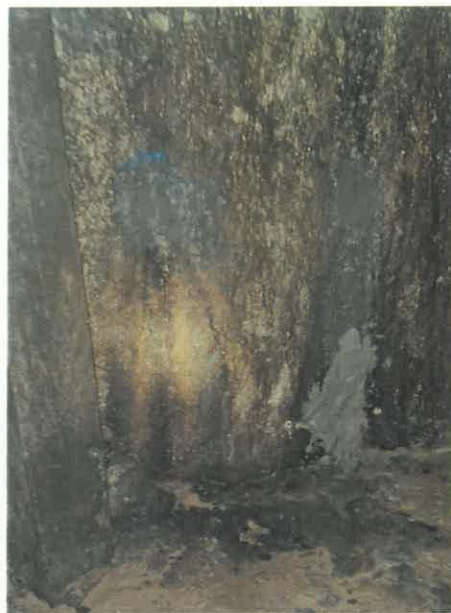
Fot. 26. Naprawy nieszczelności w ścianach żelbetowych – zdjęcie wykonane w 2023r.
