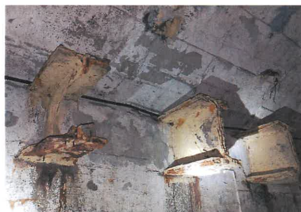
Fot. 30. Poziom -52,3m – znaczna korozja stalowych elementów konstrukcyjnych zbiornika podsadzowego, pełniących funkcję elementów stabilizujących obiekt. Brak dostępu do elementów stalowych od zewnątrz. Od wewnątrz Użytkownik wykonał próby spowolnienia korozji – zdjęcie wykonano w 2023r.
