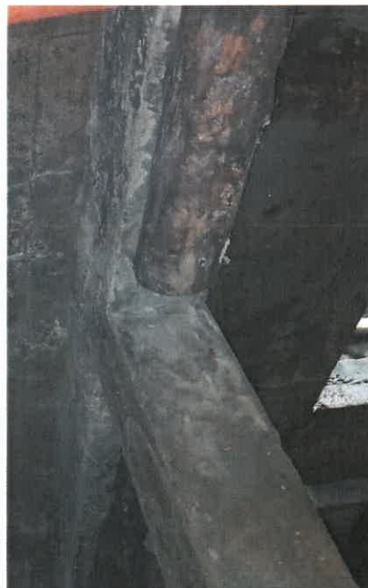
Fot. 20. Słupy żelbetowe na poziomie -57,3m – podłużne spękania słupów podpierających strop na poziomie -52,3m zabezpieczone tymczasowo przez Użytkownika – zdjęcia wykonane w 2023r.
