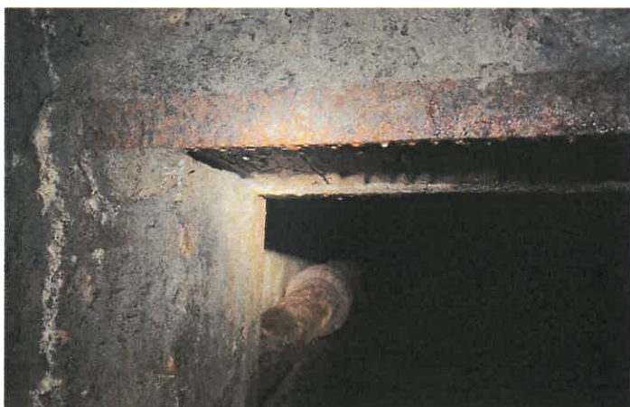
Fot. 42. Luneta – znaczna korozja stalowych elementów stolarki drzwiowej – zdjęcie wykonane w 2025r. Zabezpieczenie antykorozyjne nie zostało wykonane wg zaleceń Ekspertyzy z roku 2023. Użytkownik nie prowadzi bieżącej konserwacji elementów stalowych w obrębie lunety. Lokalne ubytki, w materiale ściennym i spoinowaniu.
