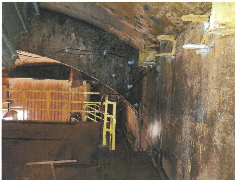
ZBIORNIK PODSADZKOWY - OBIEKT 2.c.10 - POMIESZCZENIE PODSADZKOWNI – poziom górny
