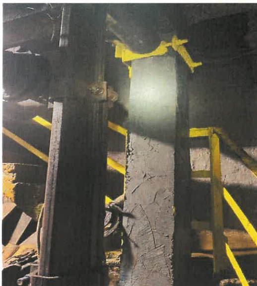
Fot. 20. Słupy żelbetowe na poziomie -57,3m – podłużne spękania słupów podpierających strop na poziomie -52,3m zabezpieczone tymczasowo przez Użytkownika – zdjęcia wykonane w 2023r.
