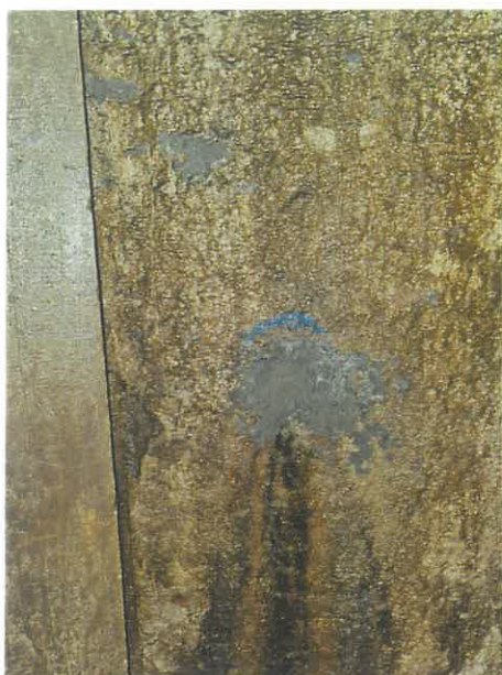
Fot. 26. Naprawy nieszczelności w ścianach żelbetowych – zdjęcie wykonane w 2023r.
