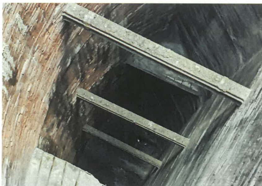
ZBIORNIK PODSADZKOWY - OBIEKT 2.C.10 - ZBIORNIK KAMIENIA
