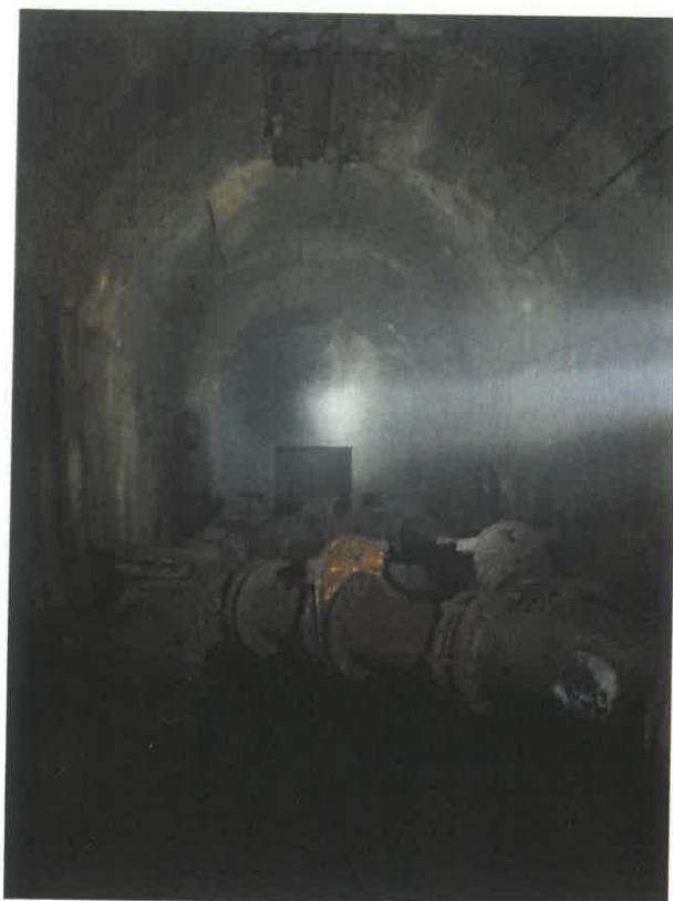
ZBIORNIK PODSADZKOWY - OBIEKT 2.c.10 - POMIESZCZENIE PODSADZKOWNI – luneta podsadzkowa.
