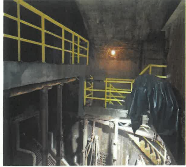
Fot. 24. Barierki zabezpieczone antykorozyjnie powłoką malarską – zdjęcie wykonano w 2023r.
