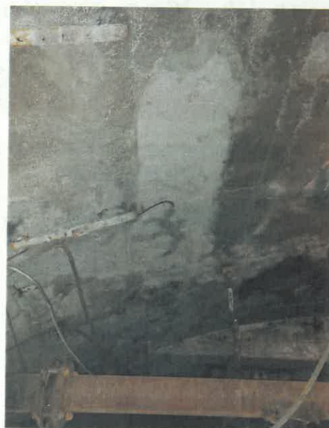
Fot. 13. Naprawy warstwy otulającej pręty zbrojeniowe wykonane w żelbetowym leju zbiornika- zdjęcie wykonane od strony pomieszczeń poniżej zbiornika w 2025r. Naprawy płyty żelbetowej wykonane przez Inwestora nie uległy odspojeniu i wykruszeniu. Brak nowych prześwitów korodującego zbrojenia.
