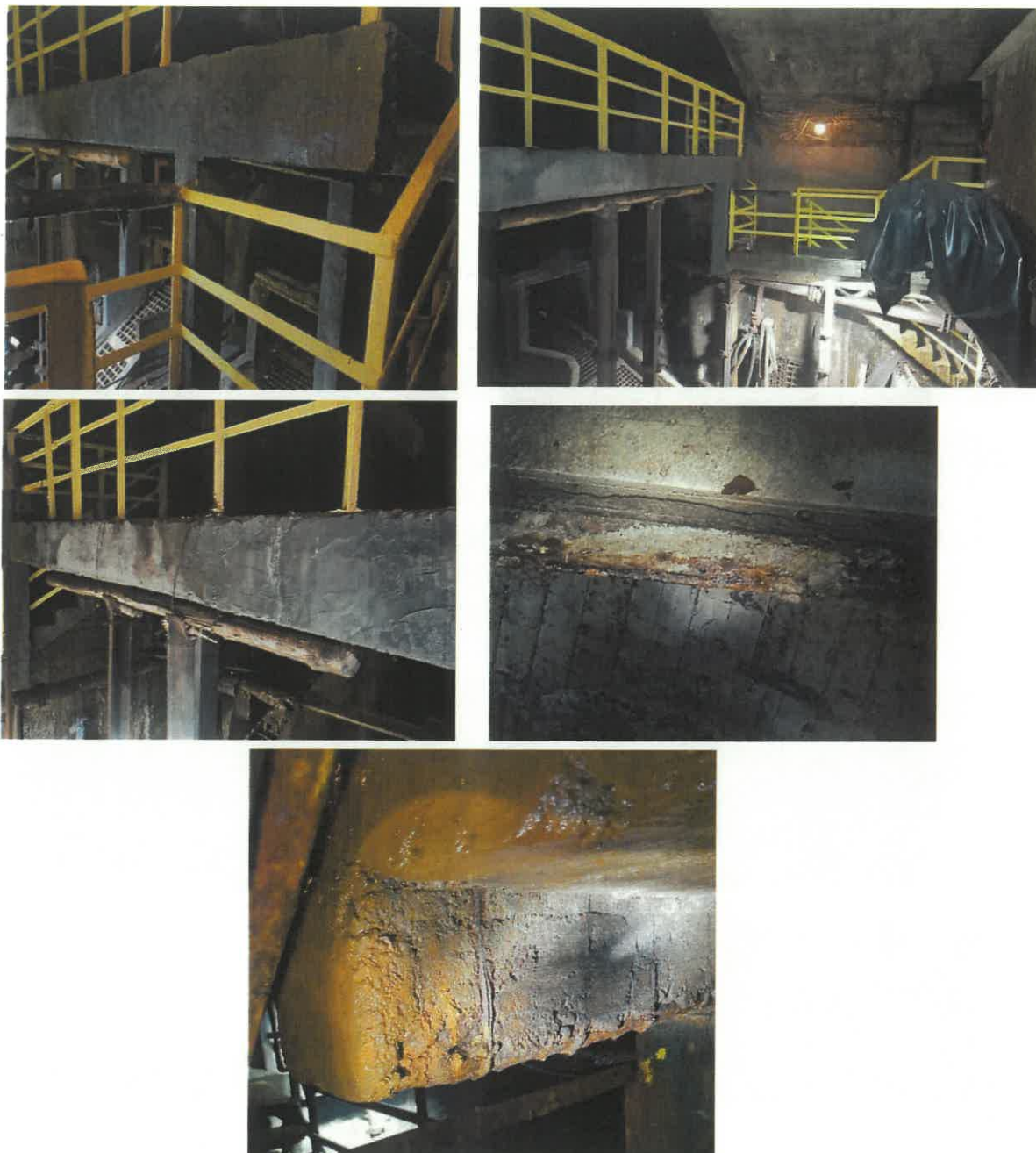
Fot. 10. Belki żelbetowe podpierające strop na poziomie -52,300m – zdjęcie wykonane w 2023r.
