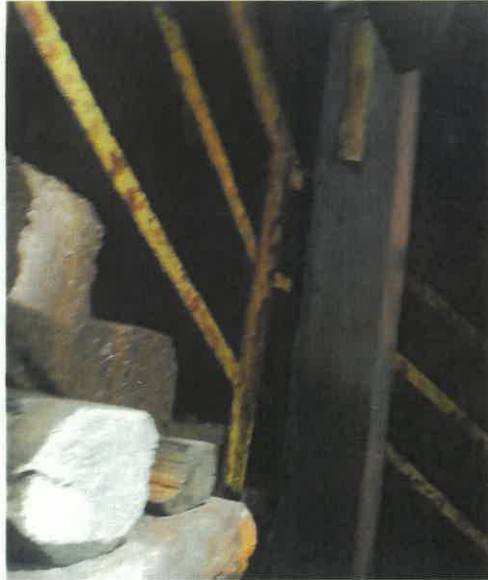
Fot. 24. Barierki zabezpieczone antykorozyjnie powłoką malarską – zdjęcie wykonano w 2023r.
