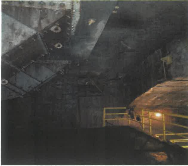
Fot. 24. Barierki zabezpieczone antykorozyjnie powłoką malarską – zdjęcie wykonano w 2023r.
