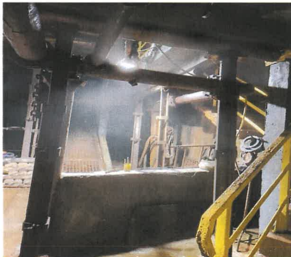
Fot. 22. Skorodowane elementy podporowe stropu pod kontenerem socjalnym zostały tymczasowo zabezpieczone (podparcie belek żelbetowych i płyty pod kontenerem socjalnym) – zdjęcie wykonano w 2023 r.
