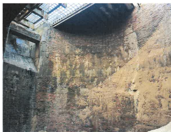
Fot. 7. Widok na ściany i przerwę dylatacyjną zbiornika piasku wykonane w 2023 r.
