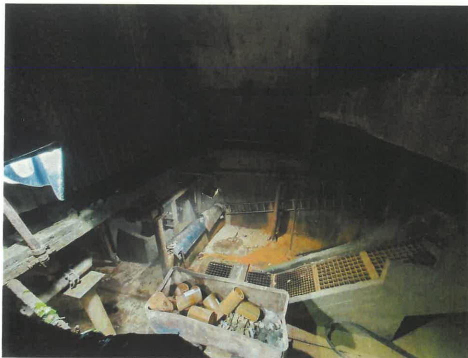
ZBIORNIK PODSADZKOWY - OBIEKT 2.c.10 - POMIESZCZENIE PODSADZKOWNI - poziom dolny
