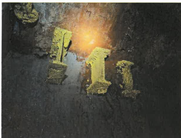
Fot. 30. Poziom -52,3m – znaczna korozja stalowych elementów konstrukcyjnych zbiornika podsadzowego, pełniących funkcję elementów stabilizujących obiekt. Brak dostępu do elementów stalowych od zewnątrz. Od wewnątrz Użytkownik wykonał próby spowolnienia korozji – zdjęcie wykonano w 2023r.
