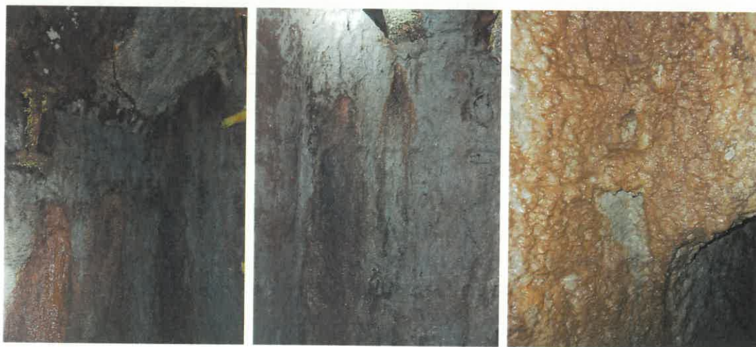
Fot. 16. Ściany pomieszczeń poniżej zbiornika kamienia i piasku – wykwyty solne powstałe na skutek oddziaływania wody wraz z zawartymi w niej związkami na ściany obiektu – zdjęcie wykonane w 2023 r.
