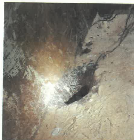
Fot. 36. Zdjęcie wykonane w 2025 r. Niezabezpieczone otwory technologiczne w stropie. Nieużywane otwory technologiczne należy zaślepić. Do czasu wykonania kompleksowego remontu należy zabezpieczyć przed osobami postronnymi.
