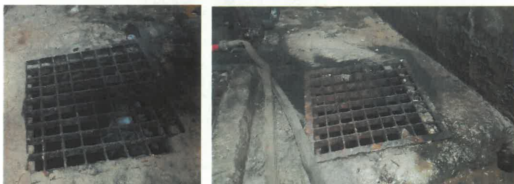
Fot. 32. Strop poziom -57,3m – Korozja krat zabezpieczających otwory lejów podsadzkowych – zdjęcie wykonane w 2023 r.
