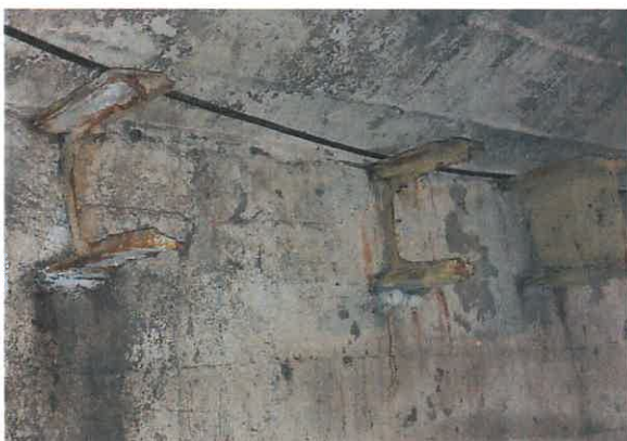
Fot. 31. Poziom -52,3m – Korozja elementów stabilizujących zbiornika. – zdjęcie wykonano w 2025 r. W 2023r. Użytkownik wykonał doraźne zabezpieczenie stalowych elementów stabilizacyjnych zbiornika. Zastosowane zabezpieczenie było wykonane doraźnie i nie zostało dopasowane do warunków panujących w obiekcie. Znaczna korozja elementów stabilizacyjnych świadczy o braku regularnych konserwacji przeprowadzanych przez Użytkownika. Miejscowo stan konstrukcji pogarsza się w szybkim tempie. Należy pilnie oczyścić widoczne części konstrukcyjne oraz zabezpieczyć w sposób adekwatny do warunków panujących w obiekcie.
