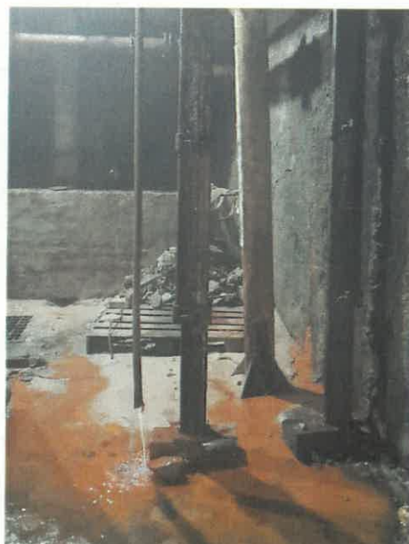
Fot. 29. Poziom -57,3m – w dalszym ciągu brak prawidłowego odprowadzenia wody technologicznej. Znaczna ilość wody w dalszym ciągu zalega na poziomie stropów, spływa po elementach konstrukcyjnych powodując ich korozję i degradację - zdjęcie wykonane w 2025 r. Należy zaplanować poprawne odprowadzenie wody technologicznej oraz zabezpieczenie elementów konstrukcyjnych i niekonstrukcyjnych przed oddziaływaniem wody z agresywnymi związkami chemicznymi.
